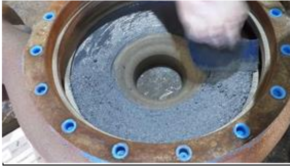
Fotografia 8 - aplicação do revestimento, polímero ARC BX1
